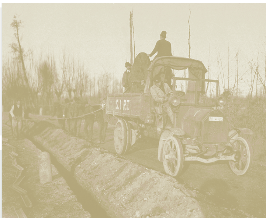
1922 - Posa del cavo Mi-Ge-To sulla Vigentina Archivio fotografico SIRT
